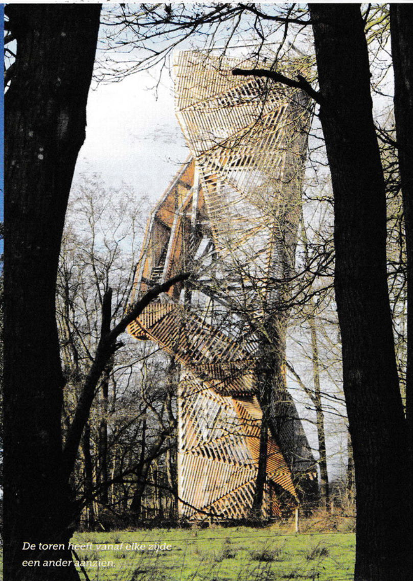
De staalconstructie is ontworpen samen met abtWassenaar. (Foto: Ateliereen Architecten)
