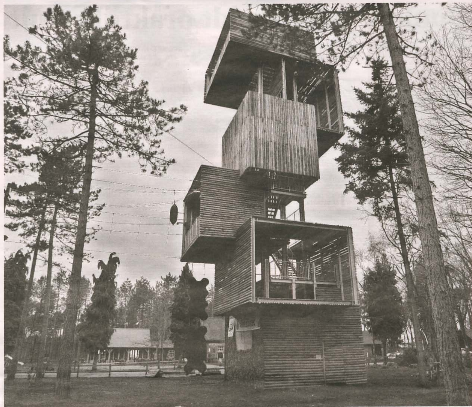
'Boom tussen de bomen': D'n Nieuwe Brandtoren in de bossen van Reusel.
